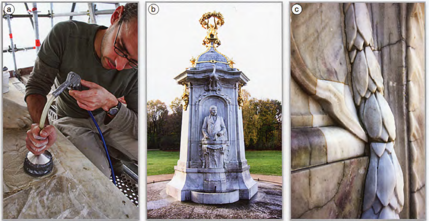
Abb. 9: a) Diplom-Restaurator Martin Lehmann beim Versuch der Reduzierung von Acrylaten von einer Figurengruppe der Schlossbrücke mittels Unterdruck. b) Das Komponisten-Denkmal im Tiergarten in Berlin. c) Risse im Fugenmörtel des Komponisten-Denkmals.
