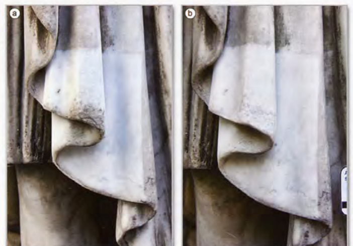
Abb. 10: a) Verwitterter Saum eines Gewandes einer Marmorskulptur an der Westfassade von Schloss Tegel. b) Nach der Konservierung mit einem KSE-Feinmörtel.
