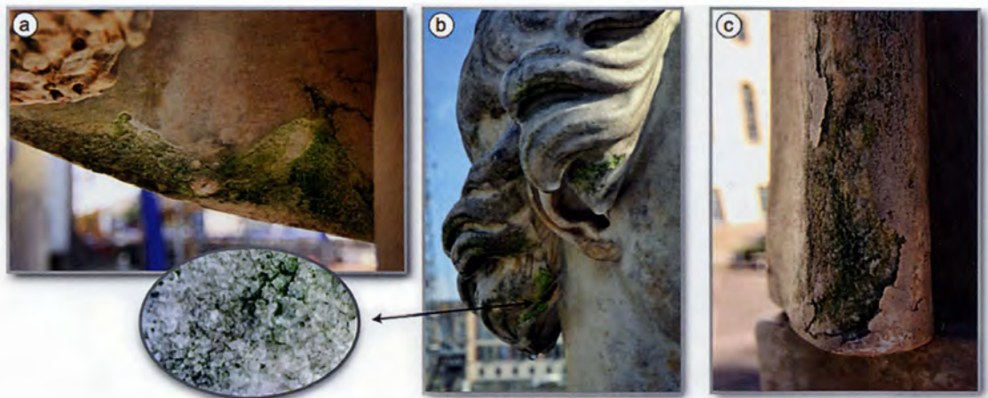
Abbildung 6: a) Algenbewuchs in stark verwitternden Bereichen im Saumbereich des Mantels. b) Algenbewuchs an abwitternden Bereichen am Lockenschopf einer Jünglingsdarstellung der Schlossbrückenfiguren und im Detail. c) Algenbewuchs hinter einer abgewitterten Antragung am Helmholz-Denkmal.
